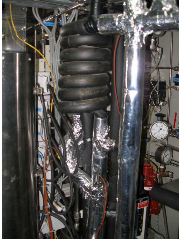
Εικόνα 7.5. Συμπυκνωτής διπλού σωλήνα και διαχωριστής V-91
